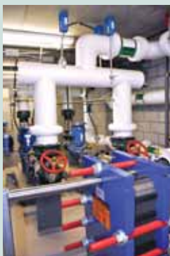
Une paire de pompes assure la circulation du mélange glycolé de la boucle géothermique. À l'avant-plan, l'échangeur à plaques qui effectue le transfert de chaleur entre la boucle géothermique et l'eau mitigée. À dr., une autre paire assure la circulation de la boucle d'eau mitigée dans les 32 étages.
