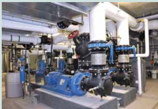
Une paire de pompes assure la circulation du mélange glycolé de la boucle géothermique. À l'avant-plan, l'échangeur à plaques qui effectue le transfert de chaleur entre la boucle géothermique et l'eau mitigée. À dr., une autre paire assure la circulation de la boucle d'eau mitigée dans les 32 étages.
