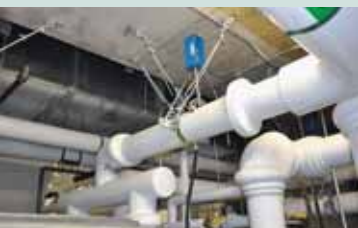
Détail des ancrages et des dispositifs parasismiques.
